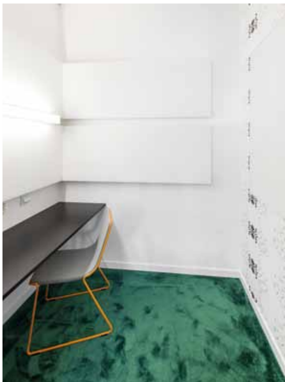
I Skype-hytterna gav 45 millimeters luftspalt mellan absorber och vägg en enorm effekt.
